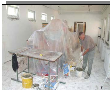
Az Evangélikus Óvoda felújítása
