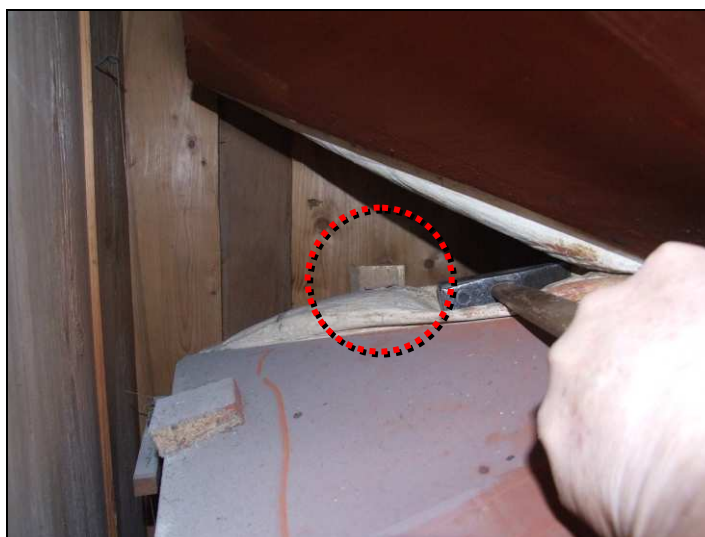
15. kép: A fúvót kitámasztó távtartó bak
